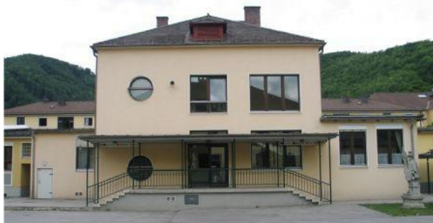
Fassade vor Projektbeginn
