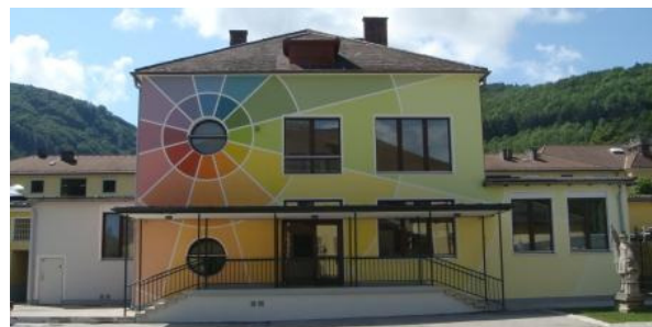
Fassade nach Abschluss des Projektes
