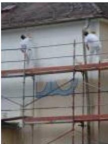
Um eine einheitliche Fläche zu erreichen, die für die Strahlkraft der 54 Farben und der weißen Trennlinie notwendig war, wurde das ausgewählte Material in einem weißen Farbton zweimal aufgebracht.
